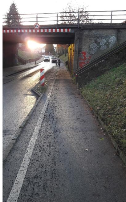
In der Karl-Marx-Straße ist der Gehweg unter der Brücke zu schmal – zumal sich diesen Radfahrer und Fußgänger teilen müssen. Zusätzlich stellen die herausragenden Handläufe eine Gefahr für Fahrradfahrer dar. Auf dem Foto ist deutlich zu erkennen, dass man die Handläufe trotz der Markierung eigentlich erst wahrnimmt, wenn man wenige Meter entfernt ist. Da man bergab fährt, kann es für ein Bremsmanöver zu spät sein. (32)
